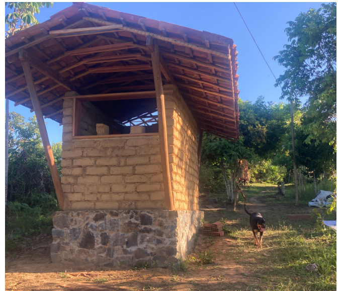
Das Badezimmer nimmt Form an
