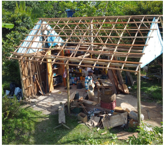
Die Garage/Werkstatt/Lager musste neu eingedeckt werden
